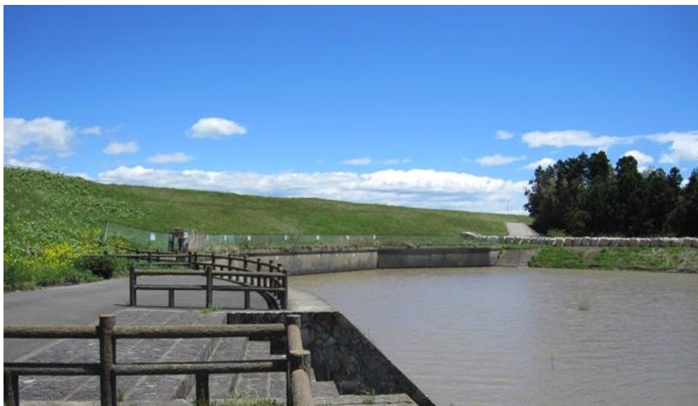
▲吉田川サイフォン出口(吉田川の下をくぐってきた鶴田川の出口=ここから高城川になる) (参考) 画像の堤防の白い点のように見えるものは、1～7までの水路番号。
