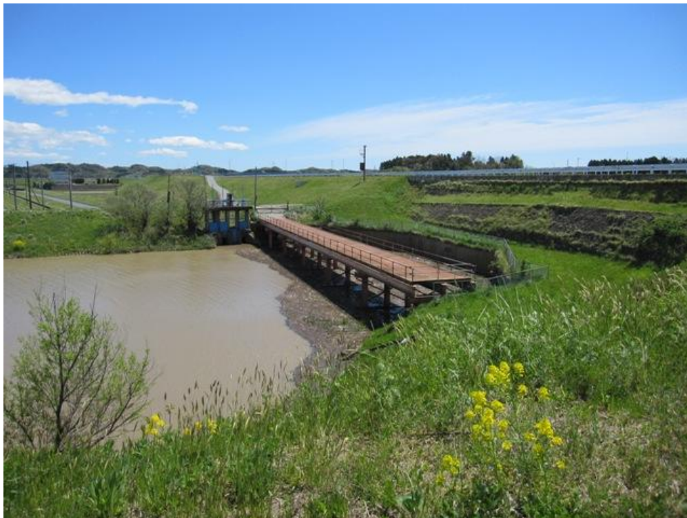
▲吉田川サイフォン入り口(鶴田川が右側の吉田川堤防の下をくぐる)
