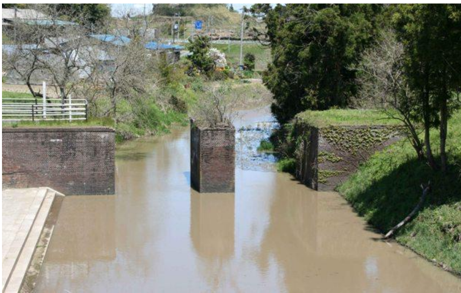
▲元禄潜穴穴頭上流側の閘門跡
